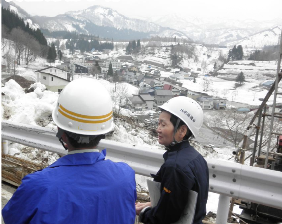
大蔵村肘折地区の県道崩落現場近くで説明を受ける渡辺ゆり子県議。現地聞き取りで「大型車が通行できなく困る」(住民)「従業員の給料に影響する」(旅館店主)などの声がかかりました。対策は待ったなしです(4月26日)
