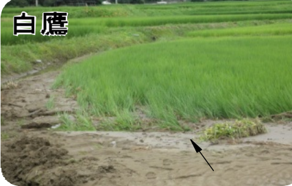
白鷹 7月22日、白鷹町貝生地区 近くの貝生川が決壊し、水田に土砂が矢印の方向から流入している様子
