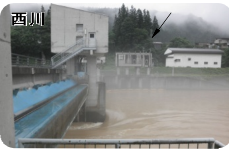
西川 7月24日、西川町取水場 寒河江川にある取水施設(矢印) 寒河江川が濁っている様子
