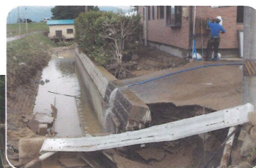
▲7月31日、河北町押切地区 水路が破壊された様子。付近では2m近く浸水した後が見られました。
